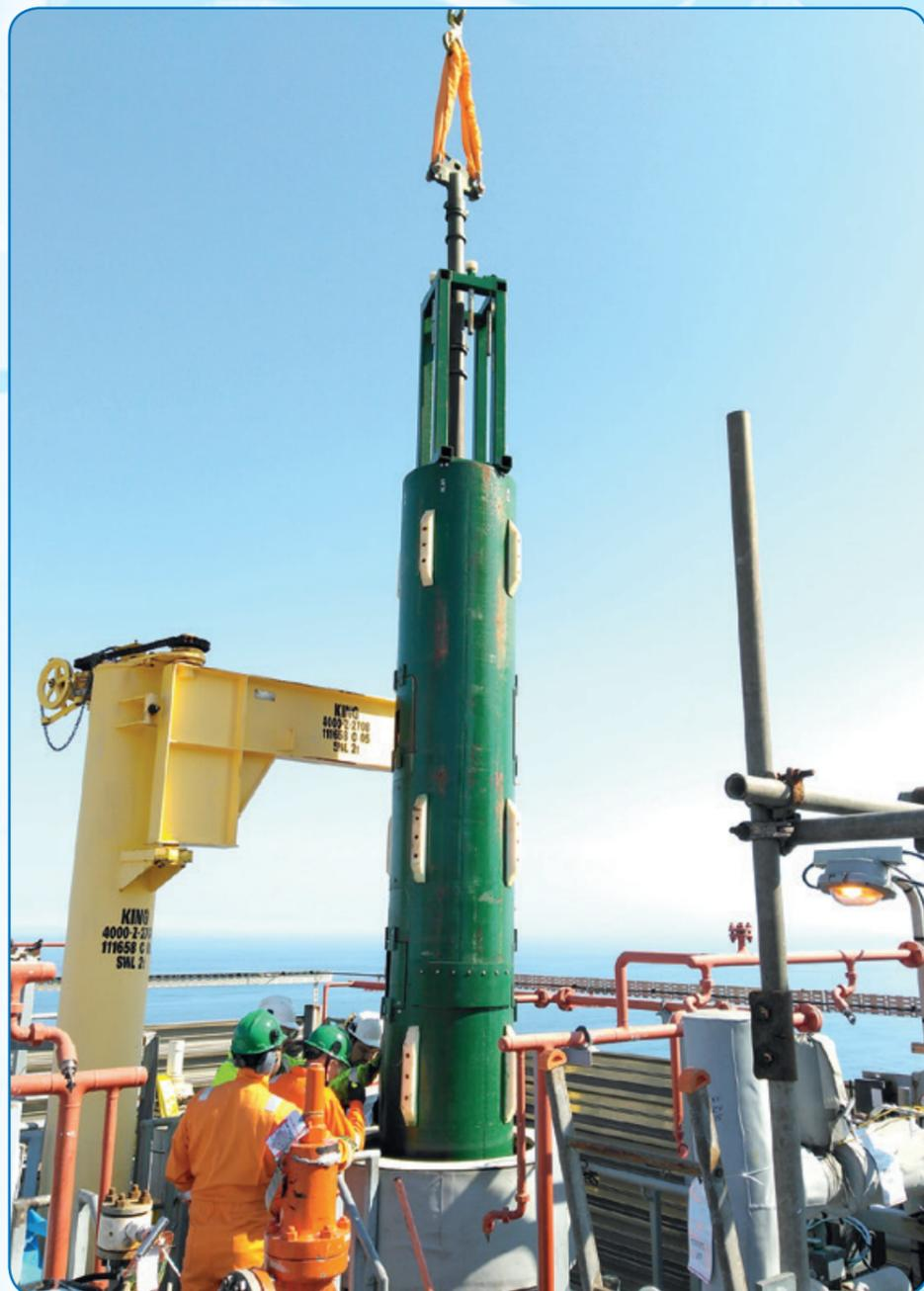
Ремонт экспортного клапана с установкой изоляционного устройства Remote Techno Plug на платформе ЛУН-А
