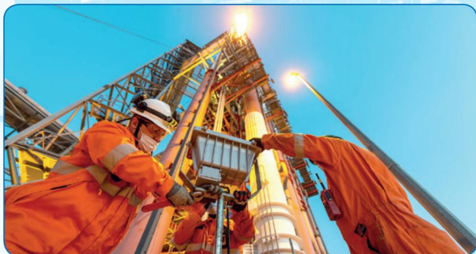
Замена оголовка одного из четырех факельных стволов на заводе по производству СПГ, ПК «Пригородное»
