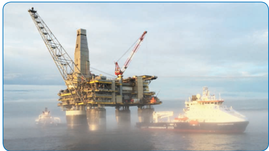
Работы по заполнению противопесочных фильтров пропантом осуществляются в теплое время года при возможности подхода специализированного сервисного судна к платформе
