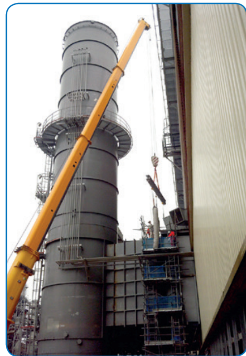
Установка компенсатора выхлопного канала газовой турбины
