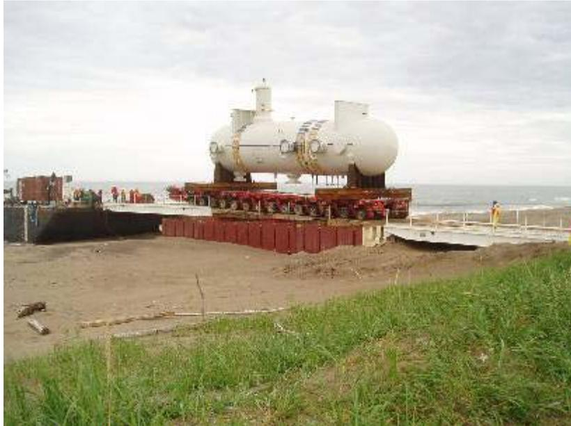
**Рисунок 14.4 Перегрузка газгольдера/резервуара для жидкости с закрепленной баржи и эстакады с использованием самоходных тележек**
