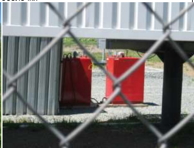
Фото 4. Расходные резервуары для хранения дизельного топлива без вторичной защитной оболочки
