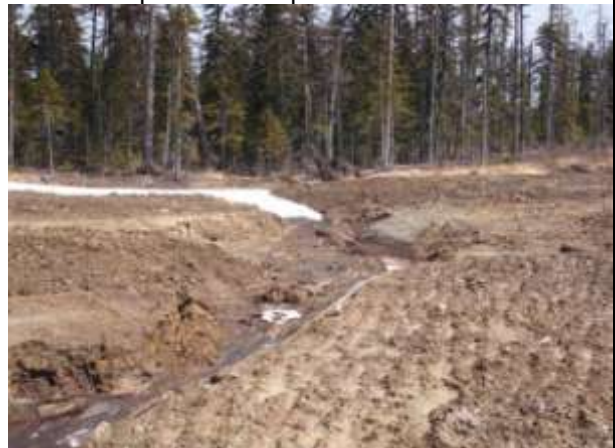
Фото 2. Образование эрозионных канавок
