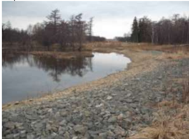
Фото 3. Иловые наносы на матрацах Рено на северном берегу
