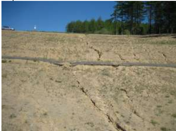
Фото 3. Развитие эрозионных канавок между раскателями склонов и отсутствие травяного покрова
