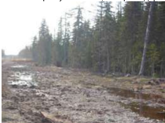
Фото 4. Переполненный рассекатель склона
