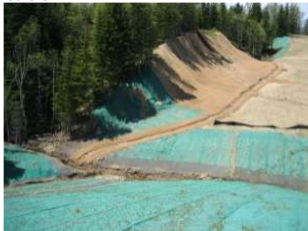
Фото 5. Улучшенная защита дренажа перехода, в том числе рассекатели склонов и геотекстиль
