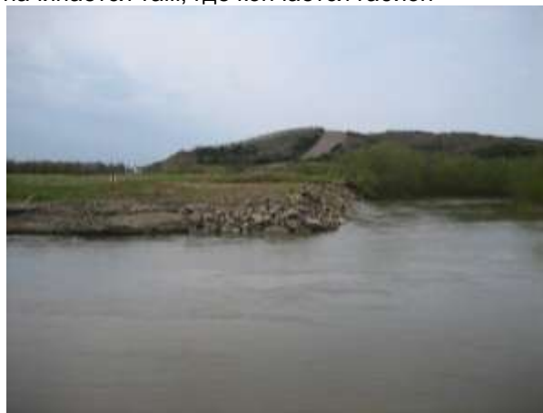
Фото 4. То же, что на фото 3, новое укрепление начинается там, где кончается габион
