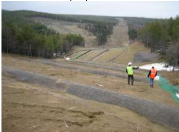
Фото 3. Размыв под рассекателем склона
