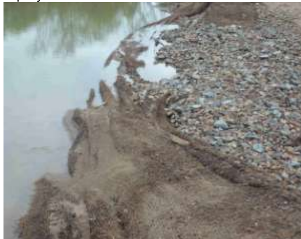
Фото 4. Поврежденная насыпь на северном берегу
