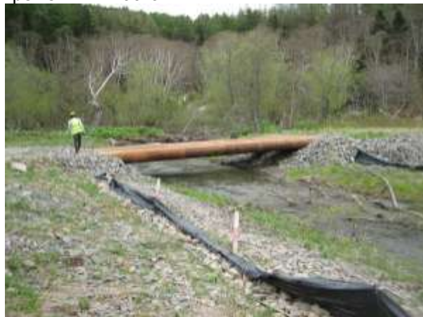
Фото 1. Вид на берег реки с матрацами Рено и временным мостом
