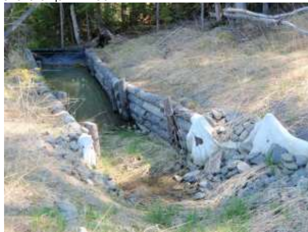
Фото 4. Ремонт противоилое ограждения
