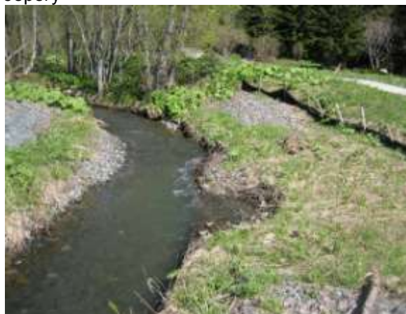
Фото 2. Вид вверх по течению, показаны укрепление берега и просадка на северном берегу
