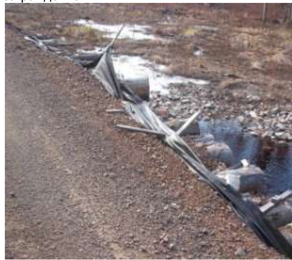
Фото 8. Поврежденное противоиловое заграждение
