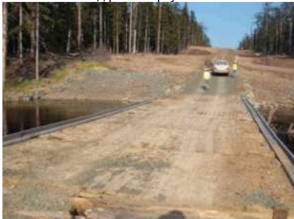
Фото 6. Мост над рекой Оркуньи
