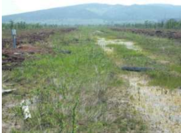
Фото 3. Спаренные насыпи над трубопроводами
