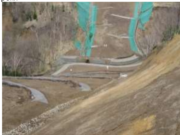
Фото 4. Вид на склоны и габионы на берегах реки
