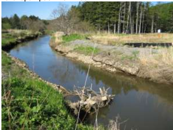
Фото 3. Вид на северный берег на переход газопровода, показаны матрацы Рено и некоторая растительность
