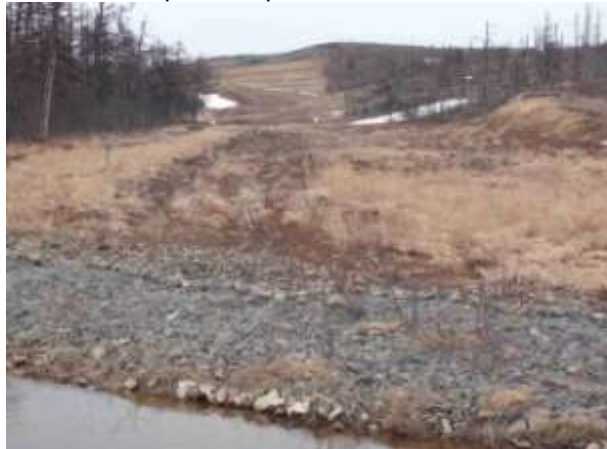
Фото 3. Промыв за рассекателем склона
