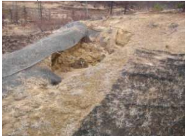
Фото 3. Промыв за рассекателем склона
