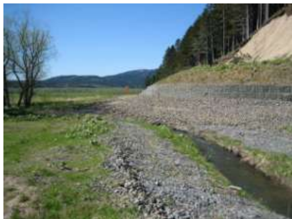
Фото 1. Вид вниз по течению, показано укрепление берега
