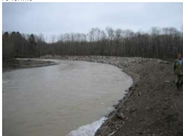
Фото 1. Укрепленный берег изгиба вверх по течению
