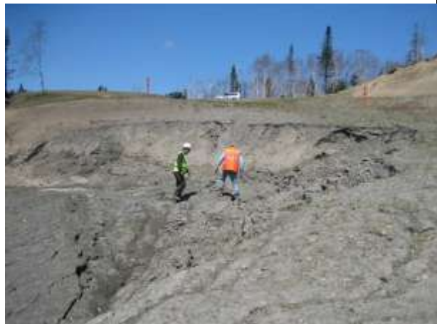
Фото 3. Вид на обрушение склона ПЗ
