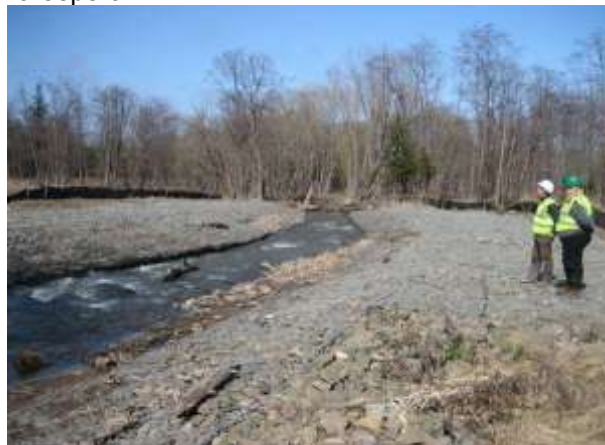
Фото 4. Поврежденная боковая выемка
