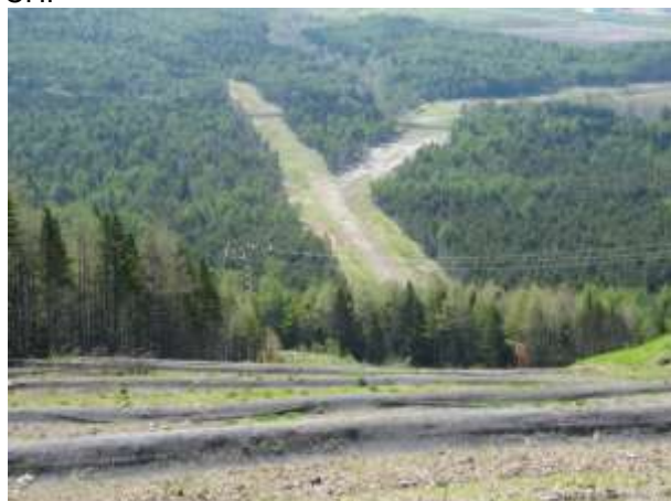
Фото 1. Вид на юг на склон реки Мерейя и расщепление ПЗ на две на подходе к заводу СПГ
