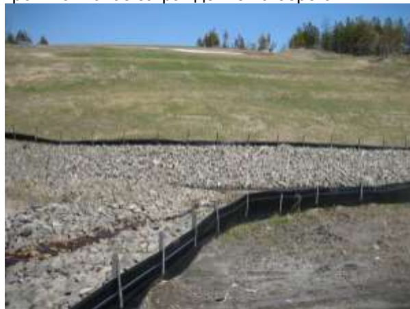
Фото 2. Вид на каменную наброску и противоиловое заграждение на берегах
