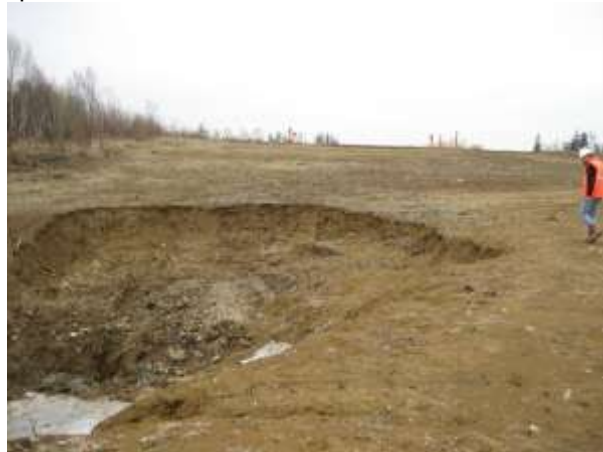
Фото 3. Размыв на прочистном отверстии дренажа
