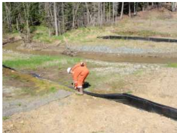
Фото 4. Ремонт противоилое ограждения
