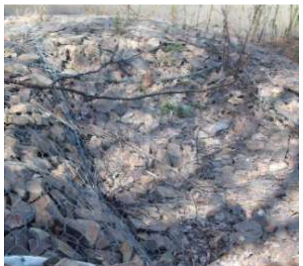
Фото 5. Просевший грунт над трубопроводом
