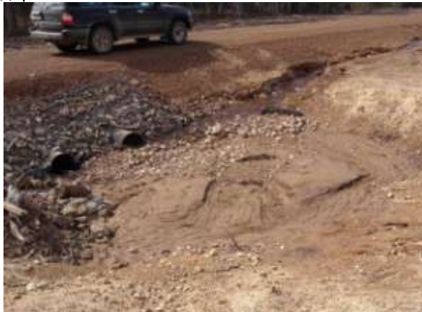
Фото 5. Забившиеся трубы на подъездной дороге
