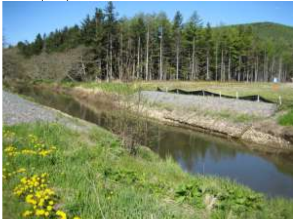
Фото 3. Вид на северный берег на переход газопровода, показаны матрацы Рено и некоторая растительность
