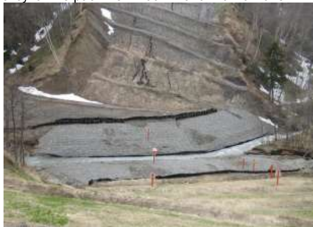
Фото 3. Вид на юг на длинный южный склон с рассекателями склонов
