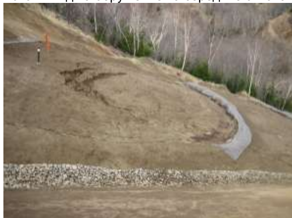
Фото 4. Вид на склоны и габионы на берегах реки
