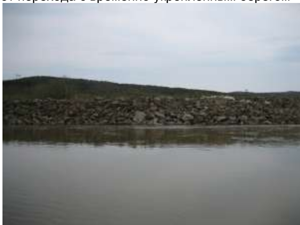
Фото 3. Вид на южный берег вверх по течению от перехода с временно укрепленным берегом
