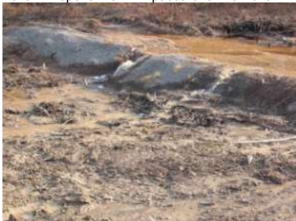
Фото 4. Переполненный рассекатель склона
