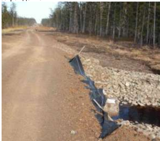
Фото 7. Поврежденное противоиловое заграждение
