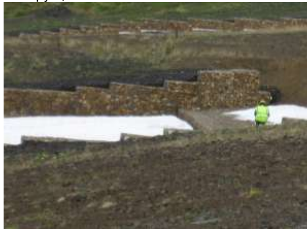
Фото 2. Вид на каскадные матрацы Рено и конструкцию габионов
