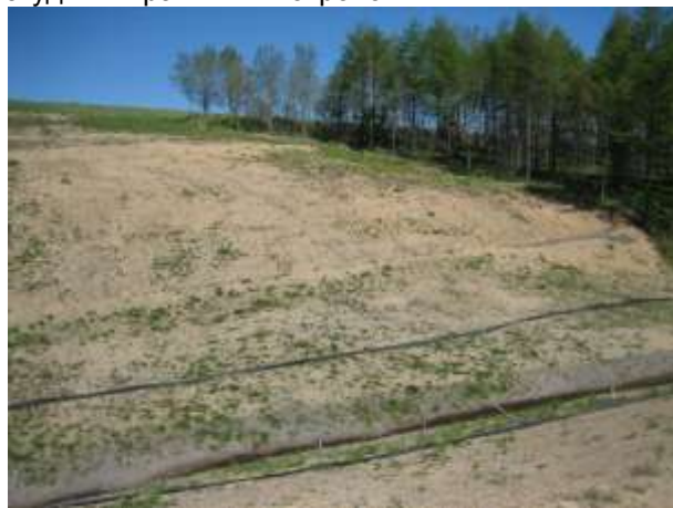
Фото 3. Вид на дренаж перехода, укрепленный геоджутом и рассекателями склонов, со скудным травяным покровом
