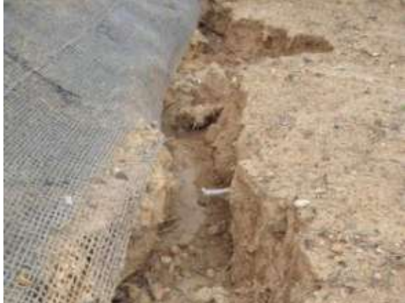
Фото 5. Размыв за раскателем склона
