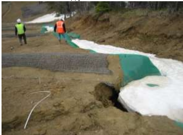
Фото 3. Размыв под рассекателем склона
