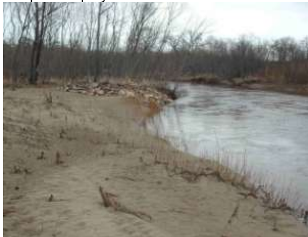
Фото 3. Иловые наносы на матрацах Рено на северном берегу
