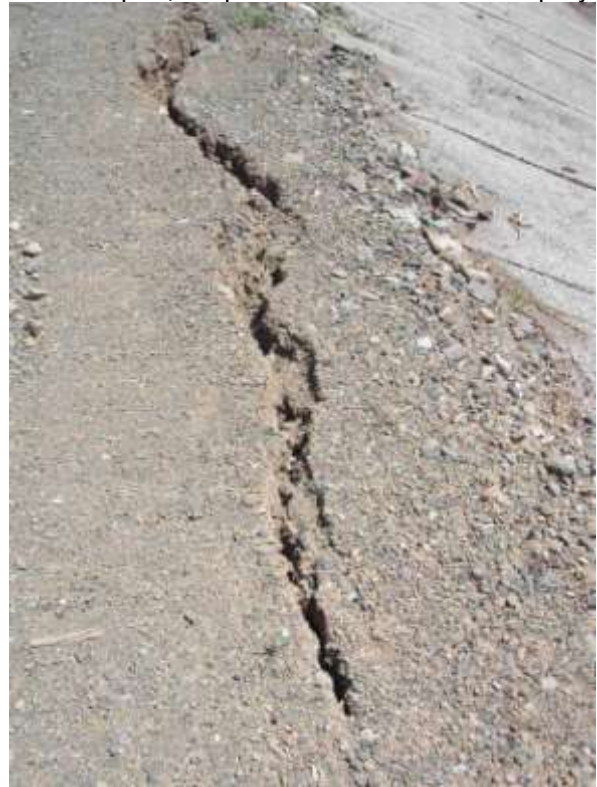
Фото 4. Трещина растяжения на южном берегу
