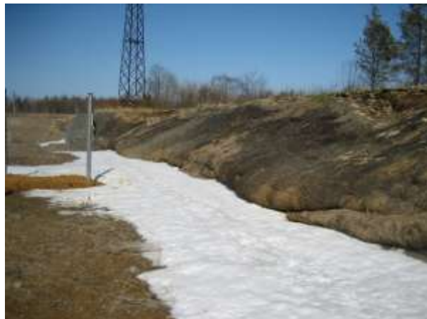
Фото 4. Поврежденная боковая выемка
