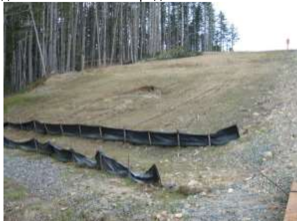
Фото 2. Вид на южный склон с признаками движения почвы на середине склона
