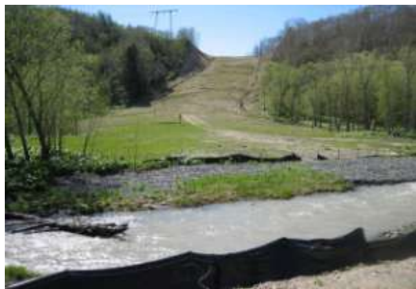
Фото 1. Вид на переход с матрацами Рено, ПЗ и южный склон с хорошей растительностью
