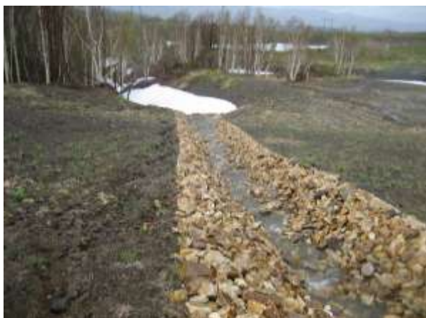
Фото 3. Укрепление дренажа перехода
