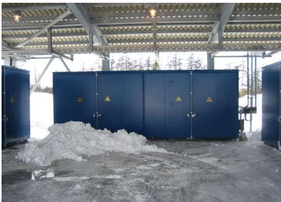
Фото 6 Новая станция перевалки отходов, ОБТК (3)
