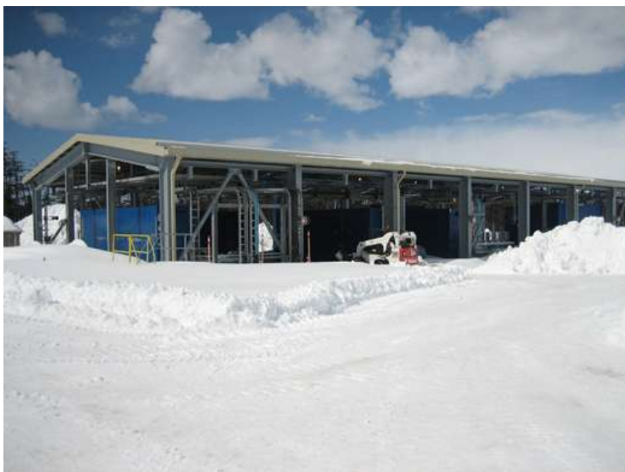
Фото 4 Новая станция перевалки отходов, ОБТК (1)
