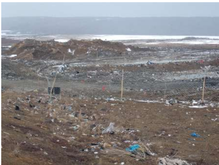
Фото 36 Защитное ограждение вокруг рабочей зоны, разнос мусора ветром сведен к минимуму, Корсаковский полигон ТБО
