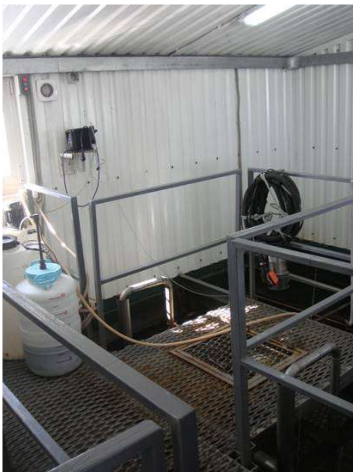
Фото 11 Дополнение к ХПА на КОС ОБТК
