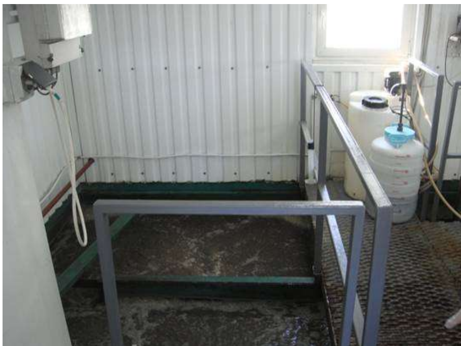
Фото 10 Система очистки канализационных стоков ОБТК
