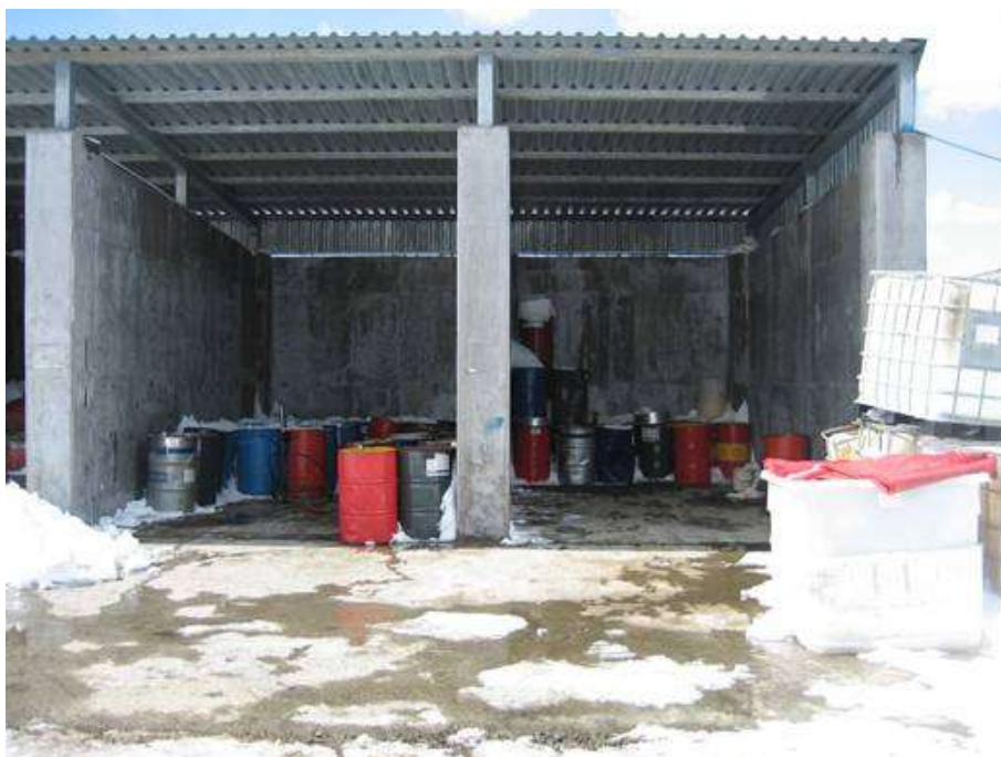
Фото 2 Отсеки для хранения опасных отходов, ОБТК
