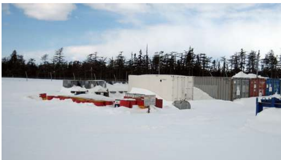
Фото 8 Зона хранения химических веществ ОБТК (1)
