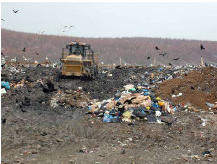
Фото 35 Уплотнение отходов на Корсаковском полигоне ТБО
