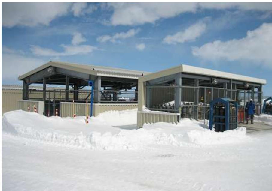
Фото 5 Новая станция перевалки отходов, ОБТК (2)
