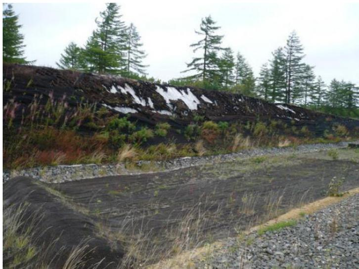
Фото 13. Разрушение геосети на переходе через разлом 1
