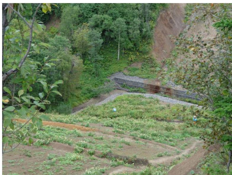
**Фото 15. Прилегающие к реке Кормовая склоны, требующие ремонта противоиловых заграждений**
