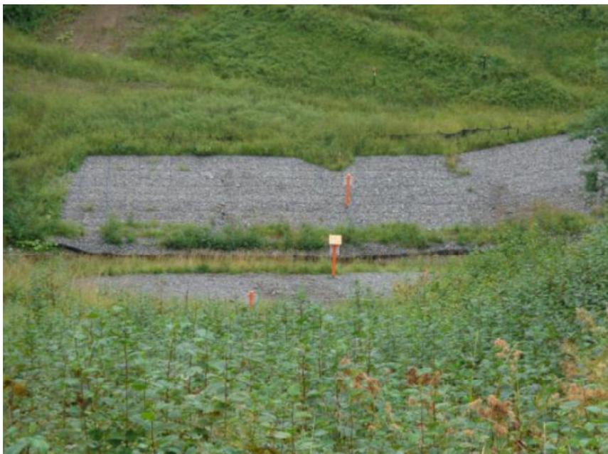
**Фото 11. Склоны на реке Кринка с плотным растительным покровом на рассекателях склона, укрепленных геоджутом**
