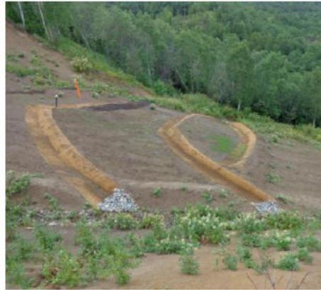
**Фото 9. Обрушение склона (2011 г.) и ремонтные работы (2012 г.) на реке Кормовая**
